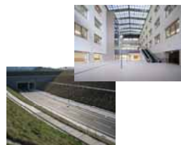
右上：平成21年5月竣工の新外来診療棟 左下：平成21年4月全線開通の構内道路1号線
