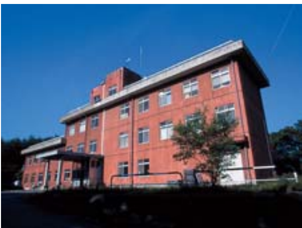
自然計測応用研究センター低レベル放射能実験施設 Institute for Nature and Environmental Technology Low Level Radioactivity Laboratory
