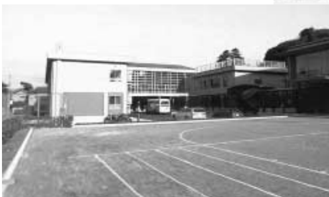
改修された校舎
